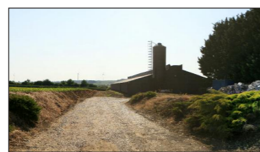
Vue silo, à Moislains
