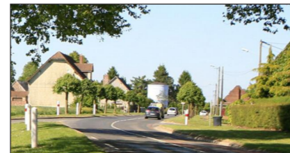
Château d'eau, à Nurlu
