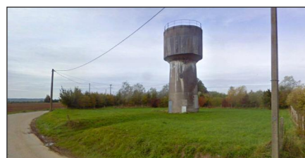
Vue silo, à Longavesnes
