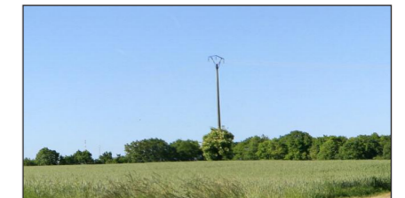
Ligne électrique, à Péronne
