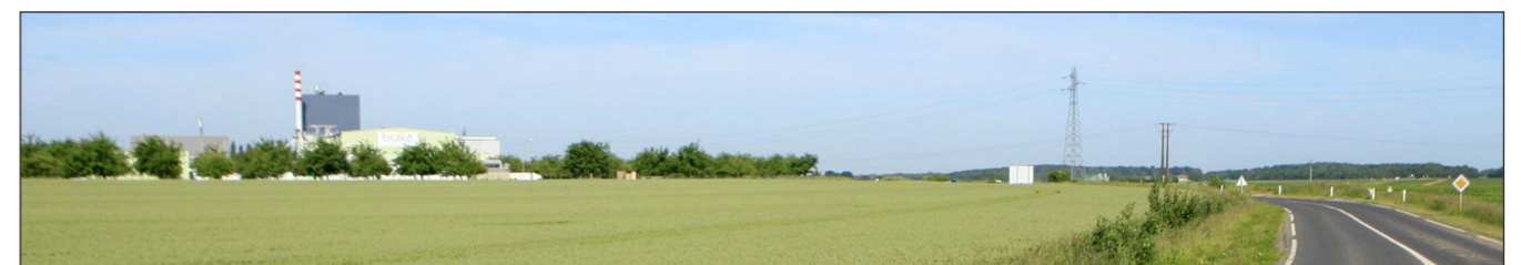
Ligne électrique et bâtiments industriels de la conserverie, à Mons-en-Chaussée
