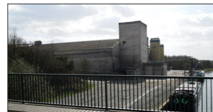
Vue silo sur quai, sur le canal du Nord
