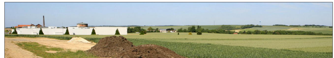
Vue du village de Roisel implanté dans la vallée de la Cologne et des bâtiments industriels implantés en plateau
