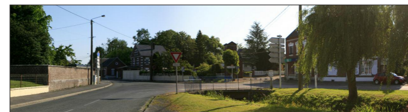
Vue du centre de Moislains
