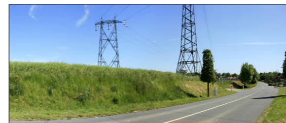
Ligne électrique, à Roisel
